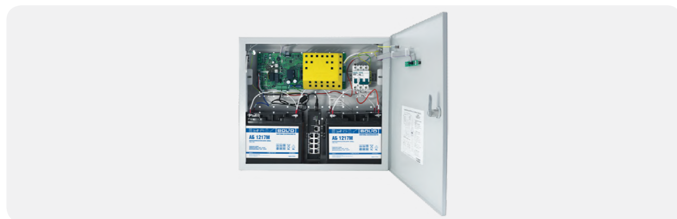
Рисунок 76. РИП-48 исп.01 с установленным внутри коммутатором SW-108
